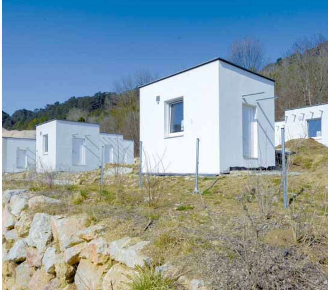
Park badawczy Baumit Viva przy zakładzie produkcyjnym Baumit w Wopfing (Austria).
